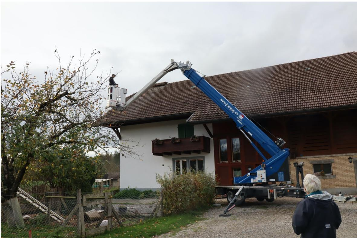
Auch hier wird die Horstunterlage (am linken Dachrand) entfernt. Dazu muss das Holz vorgängig mit einem Spannsatz gesichert werden ...
